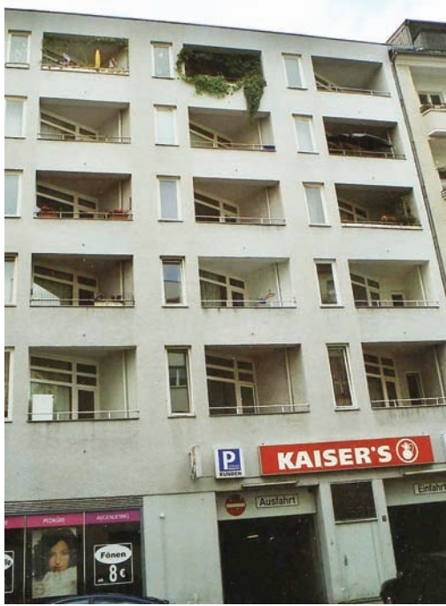
Abb. 2: Standort des Balkons (fünftes Stockwerk, Mitte) in eng bebauter Wohnblockzone
