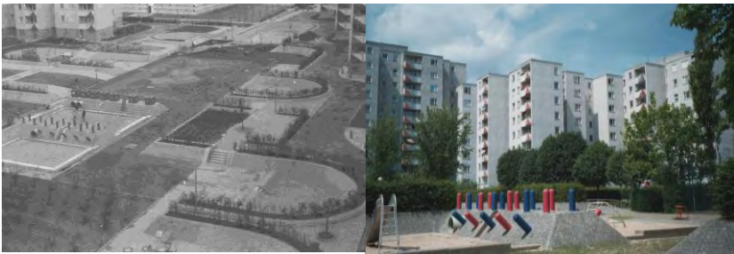
Abb. 27: Innenhof am Senftenberger Ring (rechts bereits wieder sanierte Gebäude) Winter 1971/72 Foto: L. SCHLOTTKE Sommer 1998 Foto: W. OTTO
