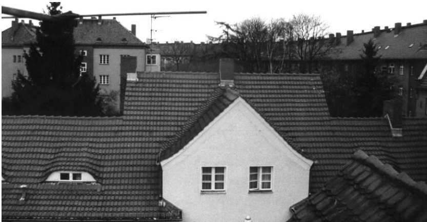
Abb. 2: Überblick auf die Reihenhaussiedlung (1920) und die Blockbebauung aus den 30er Jahren
