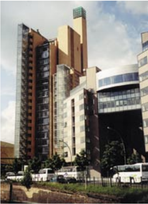
Abb. 13: Debis-Haus am Reichpietschufer
