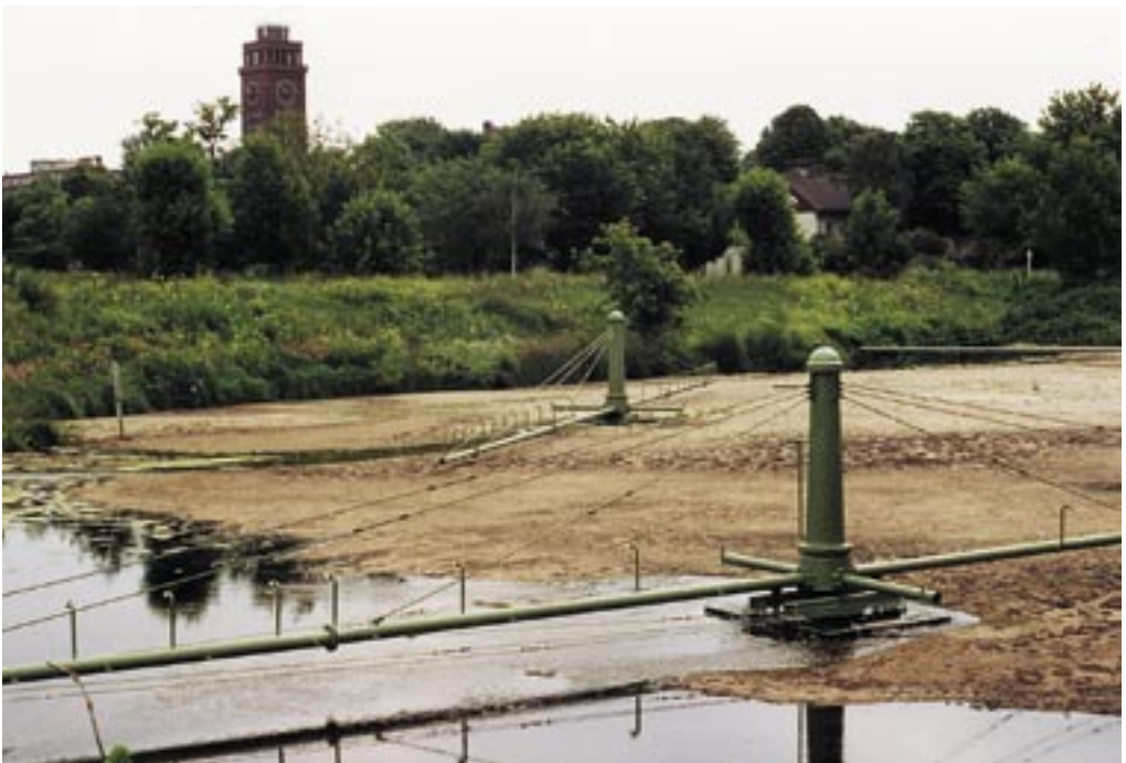
Abb. 76: Versickerungsfläche im Wasserwerk Jungfernheide
